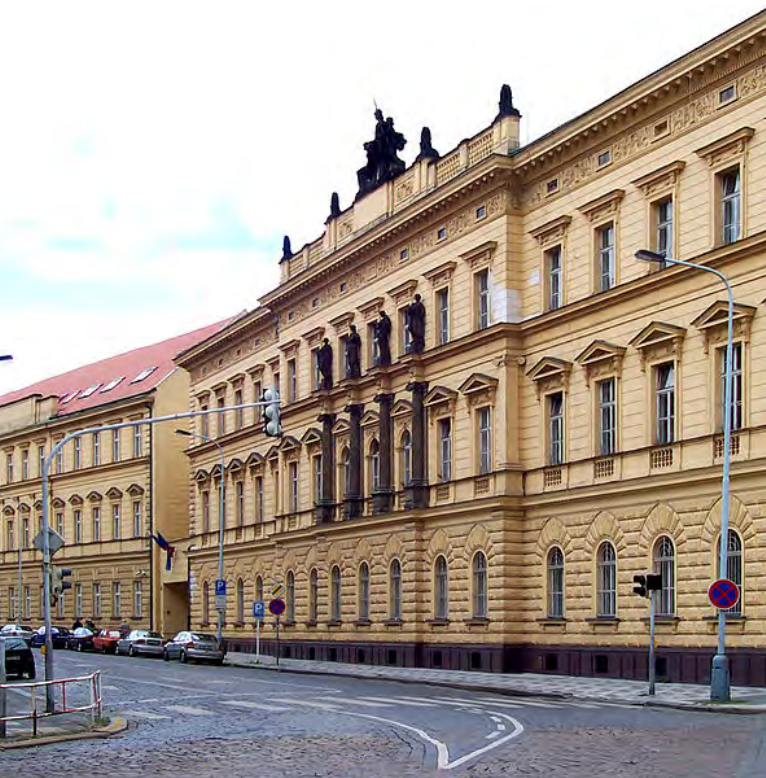
Budova Ministerstva spravedlnosti [2]
