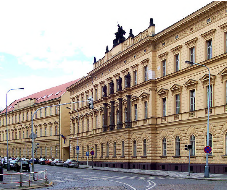
Budova Ministerstva spravedlnosti [2]
