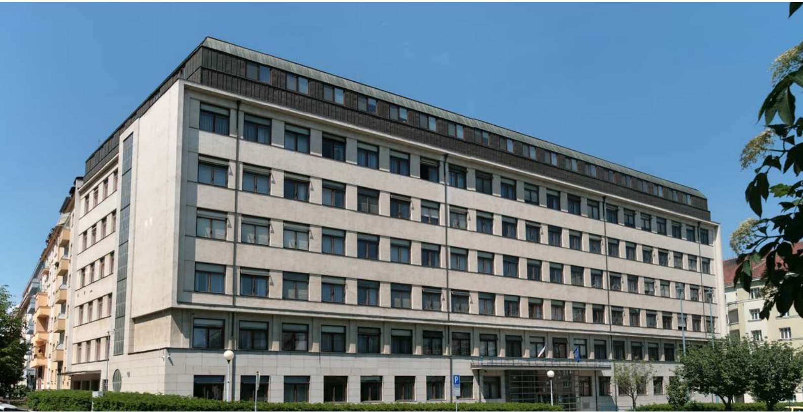
Budova Nejvyššího soudu České republiky [2]
