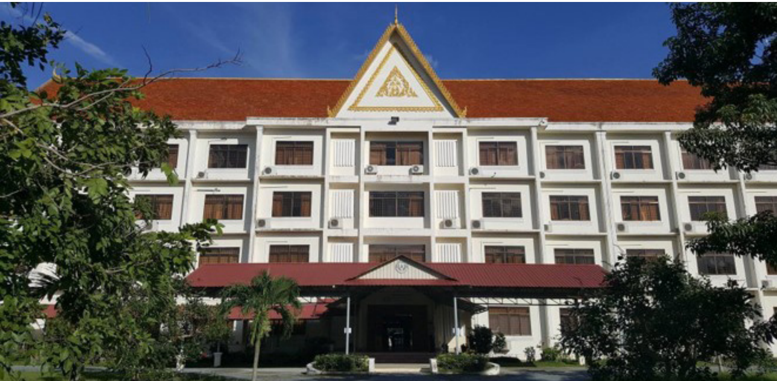
Budova Zvláštních senátů soudů pro Kambodžu [2]
