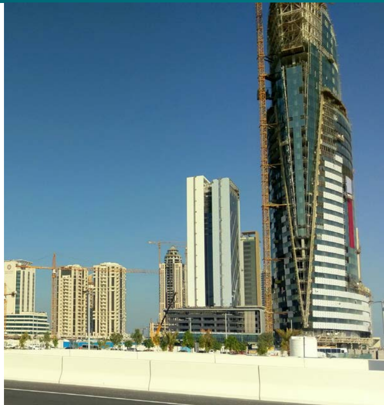
Výstavba nového města Lusailu [1]
